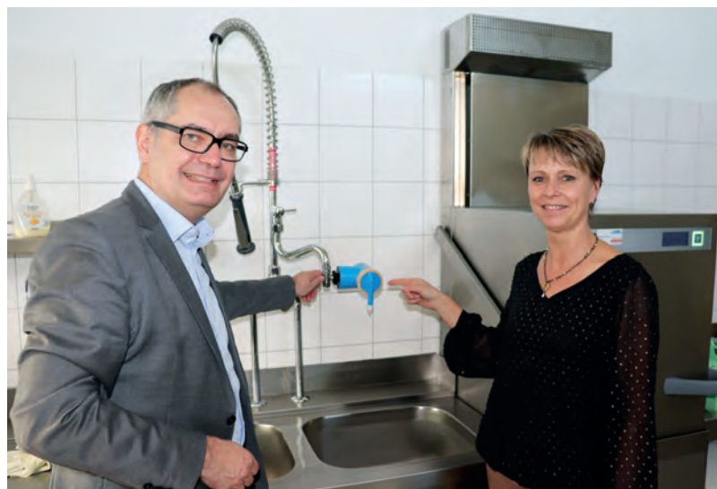
Sofortmaßnahme in Kinderbetreuungseinrichtungen: der Einbau von Chlorfiltern. Anita Ellinger, Leitung der Kindervilla Tiefenbacher, freut sich über diese Unterstützung.
