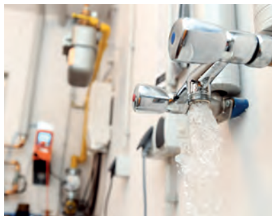
Ca. 4.800 Hausinstallationen werden überprüft
